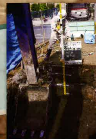
Ⅵ. 締め固め作業
