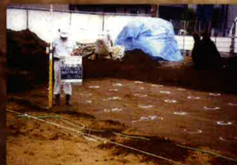
Ⅷ. 改良天端確認
