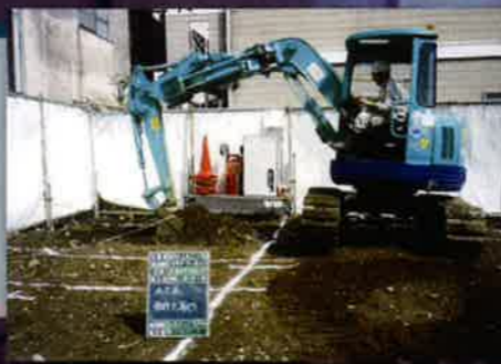
Ⅰ. 原地盤土の鋤取り
