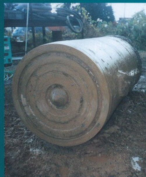
築造コラムの出来形確認 (着底部形状)
