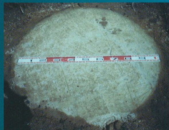
築造コラムの出来形確認 (頭部形状)
